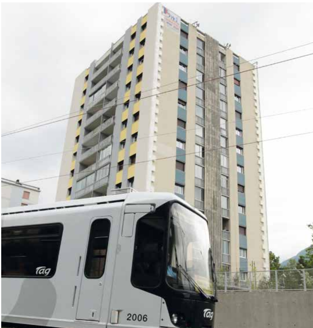
Les travaux d'isolation par l'extérieur de La Pinea 3 dans le cadre de Mur/mur 1
