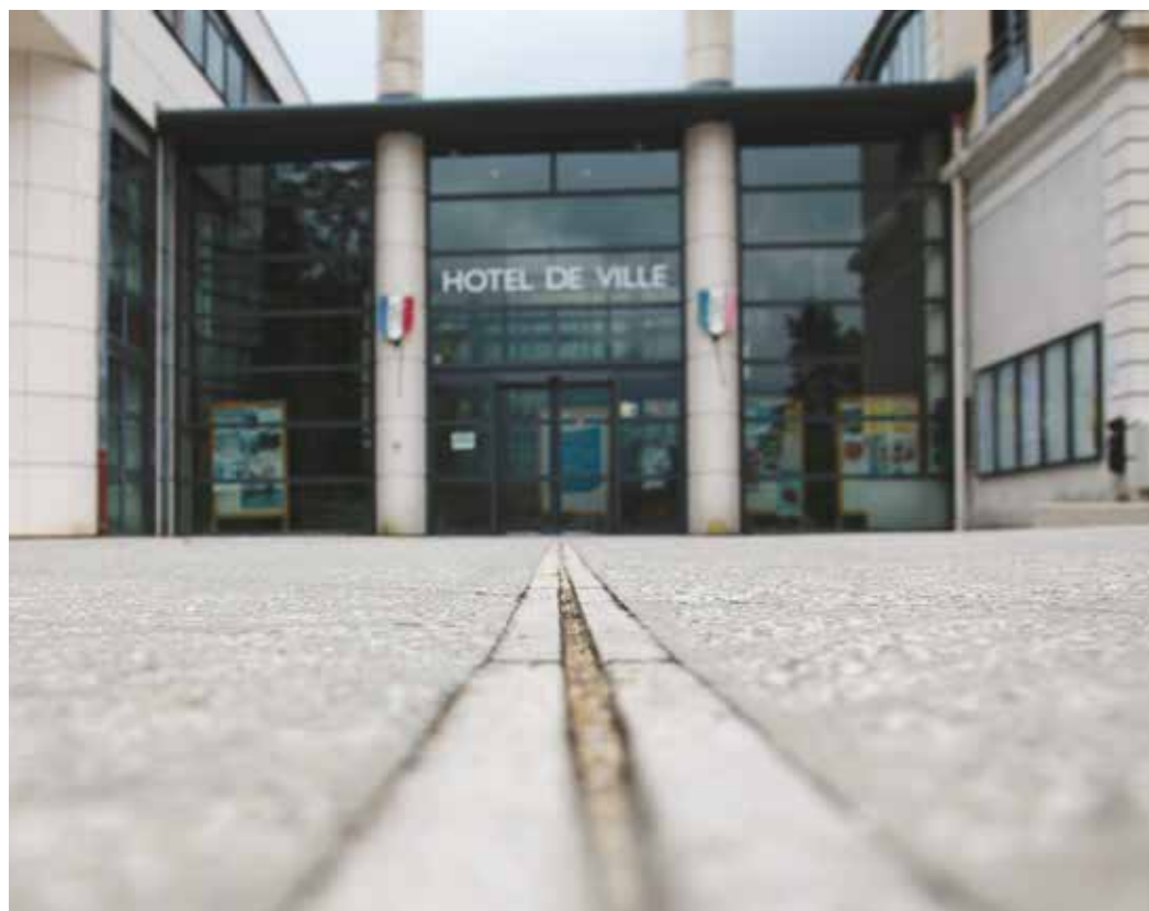
Un aménagement permettant de guider les mal voyants vers l'entrée de la mairie
