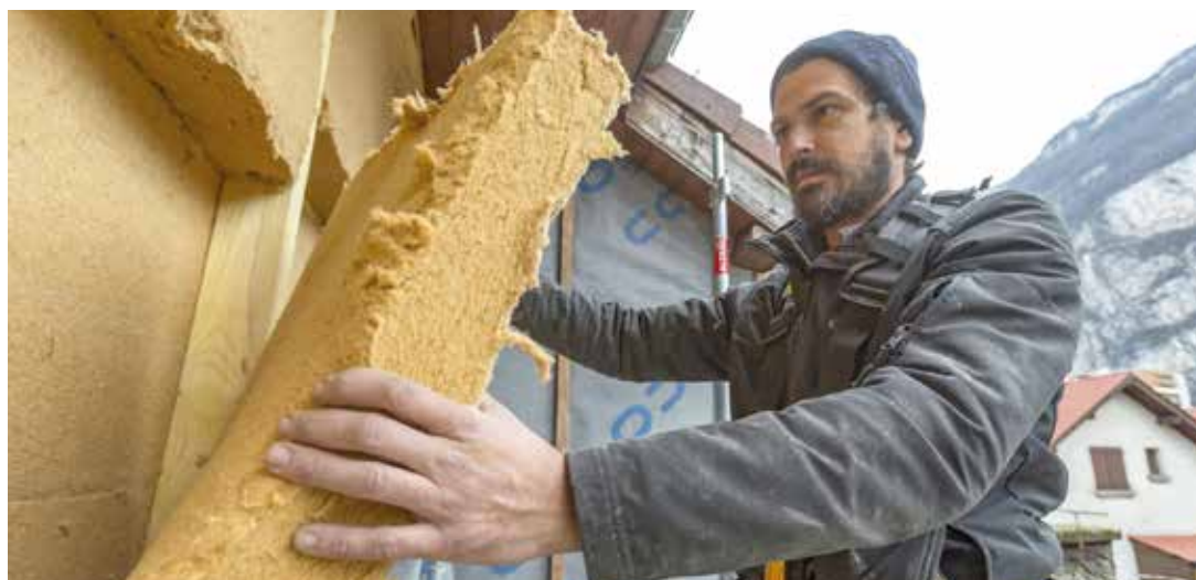
Travaux d'isolation par l'extérieur
