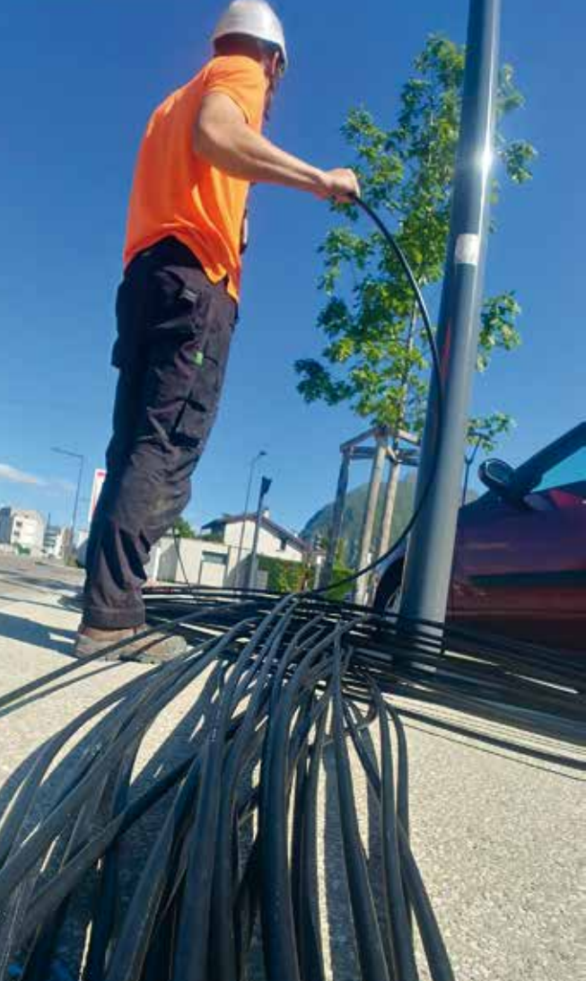
Installation de la fibre optique pour la vidéoprotection
