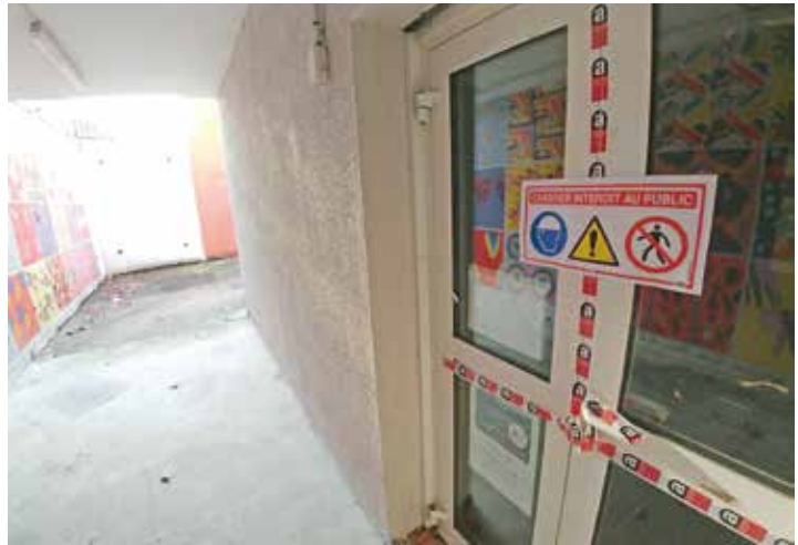
Pendant les travaux, le vestiaire de la solidarité est accessible par l'entrée principale de la MSF
