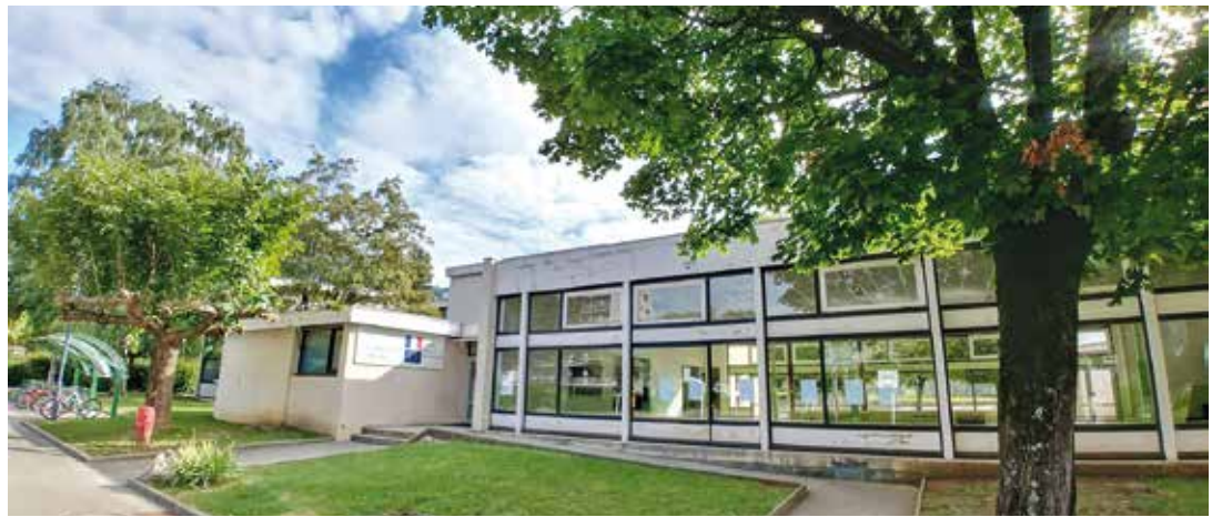
La réhabilitation de l'école Barnave sera le plus gros chantier entrepris sur les bâtiments scolaires de la Ville depuis quelques années
