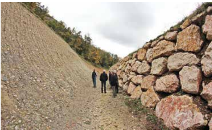
Un merlon créé dans le cadre des travaux de sécurisation du Néron
