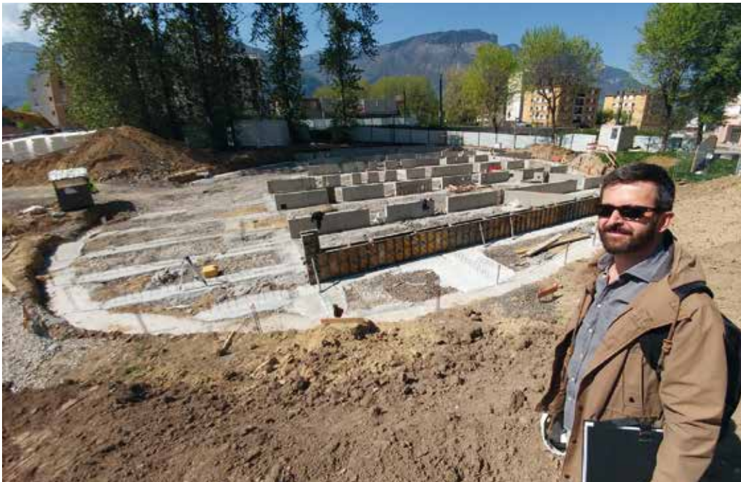
Barthélémy Antoine, du cabinet R2K, devant les fondations du Pôle enfance
