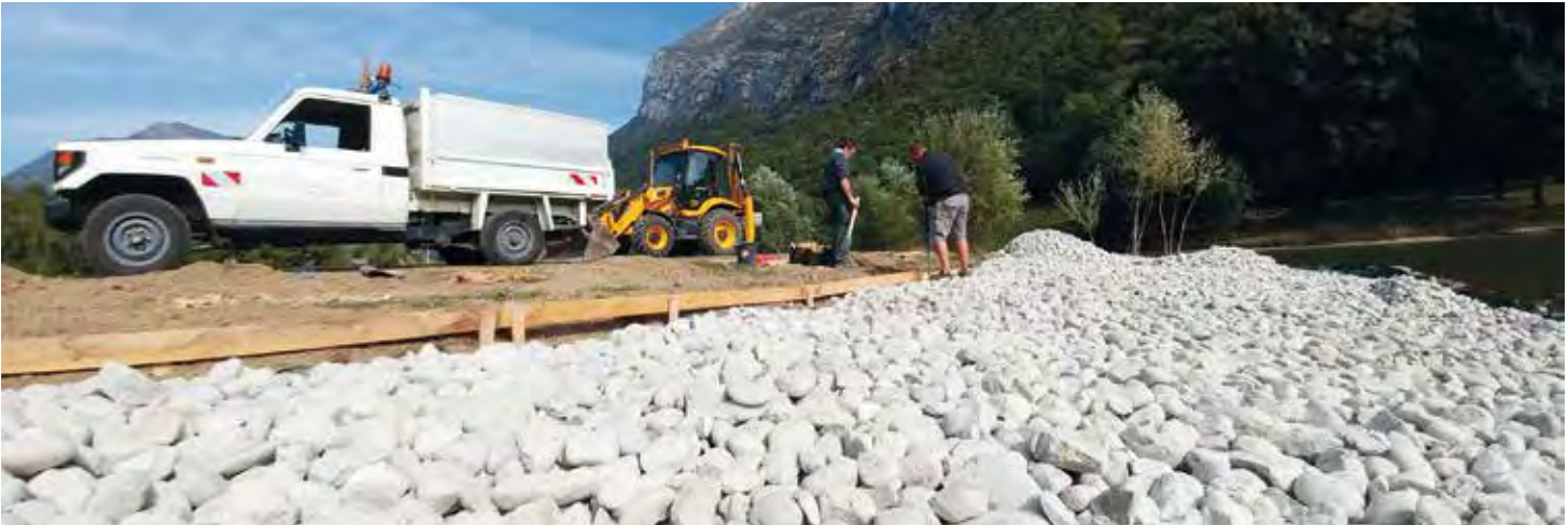
Des galets utiles pour stabiliser les berges du lac de Fiancéy
