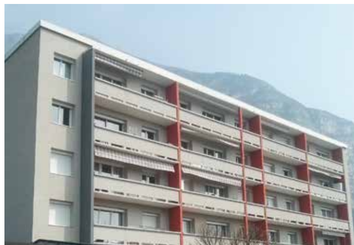
Les Catalpas à Prédiu, une des résidences saint-égrévoises rénovées dans le cadre de Mur/mur 1
