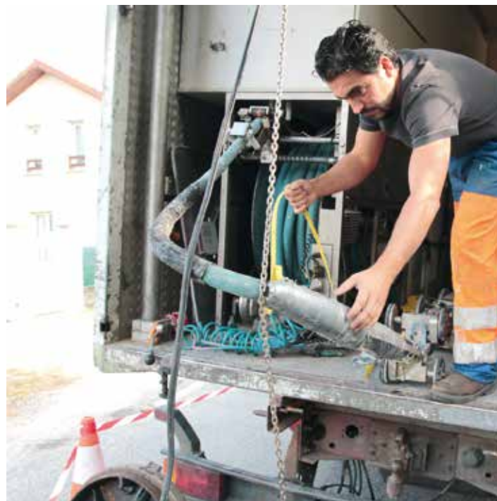
La Métropole utilise un robot pour explorer les canalisations d'eaux usées
