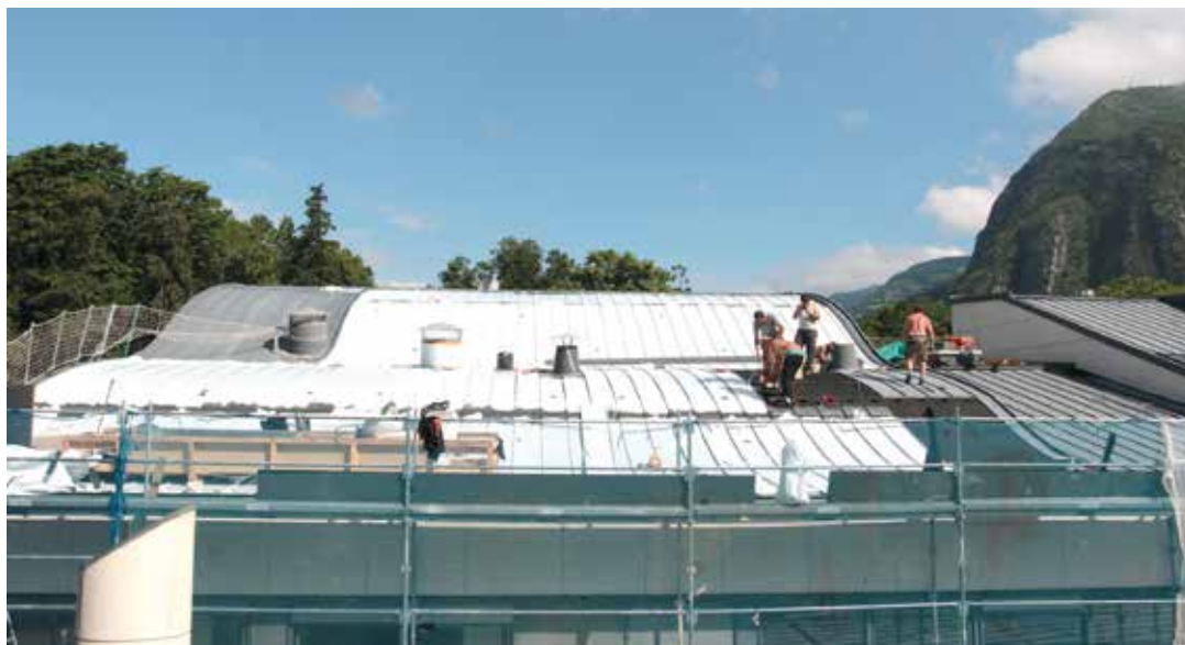
Les quelque 1000 m 2 de panneaux photovoltaïques installés par Saint-Egrève produisent 70 384 kwh, soit 2,6% de la consommation électrique annuelle totale de la Ville ou l'équivalent de celle de 13 foyers
