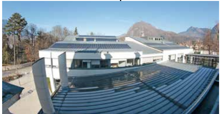
Les membranes photovoltaïques de la mairie vont être changées
