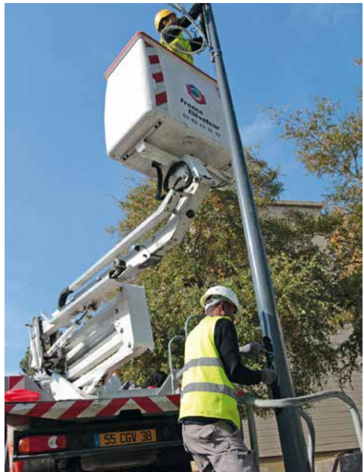
Agents des ateliers municipaux installant des éclairages LED à Prédiou
