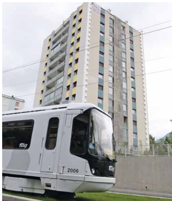
La Pinéa en cours de rénovation grâce à Murmur 1 (archives)
