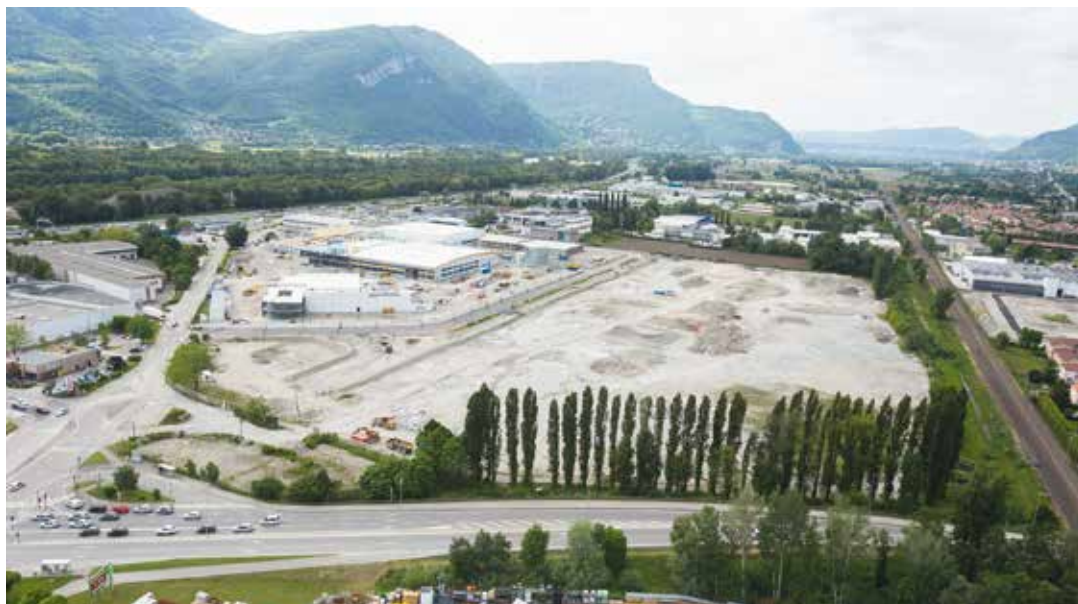
Entrée nord de Saint-Egrève : le terrain de l'ex-ETAMAT où seront implantés les cinq restaurants
