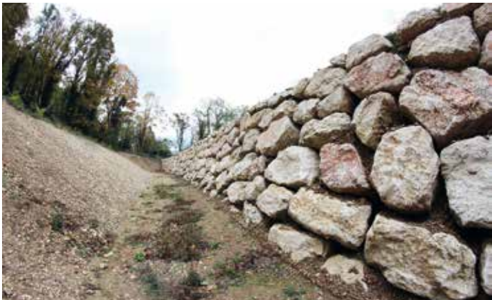
Avant la pose de filets, des merlons (photo) avaient été installés pour sécuriser le Néron
