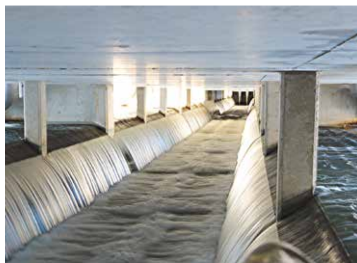
Dernière étape : l'eau nettoyée est prête à être rejetée dans l'Isère
