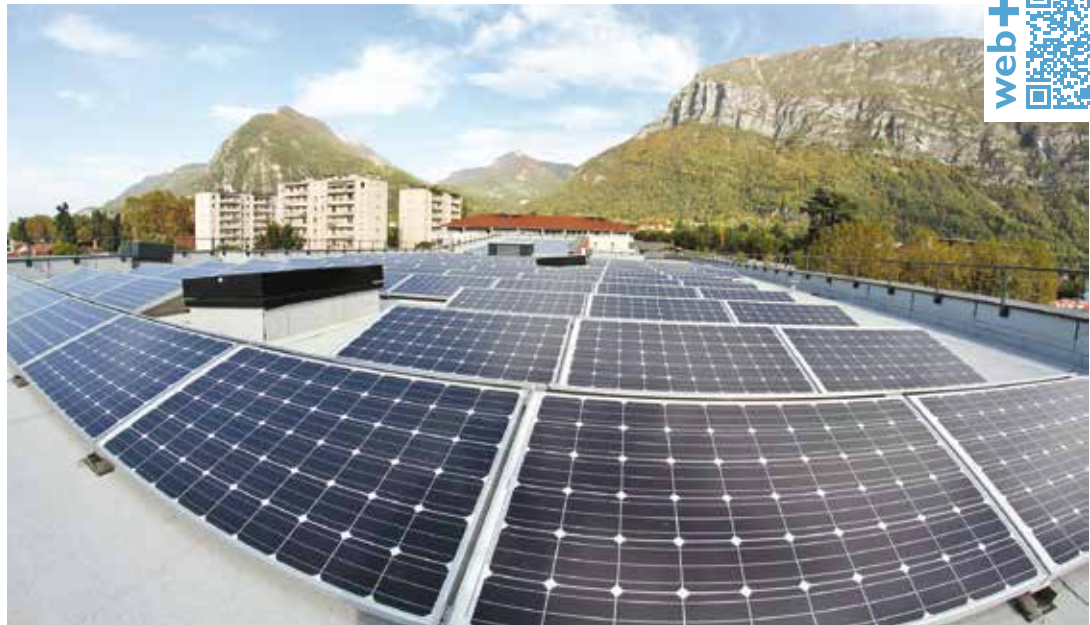
Les 380m 2 de panneaux photovoltaïques implantés sur le toit de La Vence Scène
