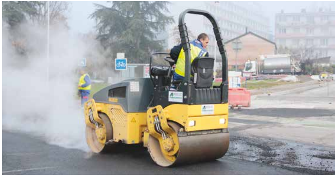
Les travaux de voirie seront pris en charge par La Métro dès le 1 er janvier 2015
