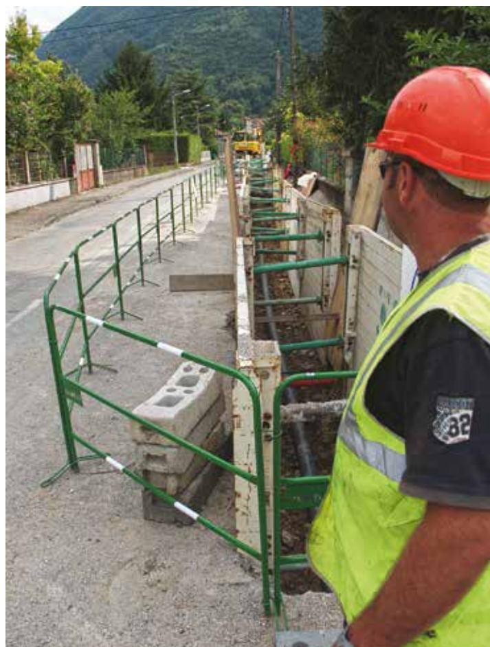
Après les travaux sur les réseaux (notre photo), le chantier de requalification va commencer
