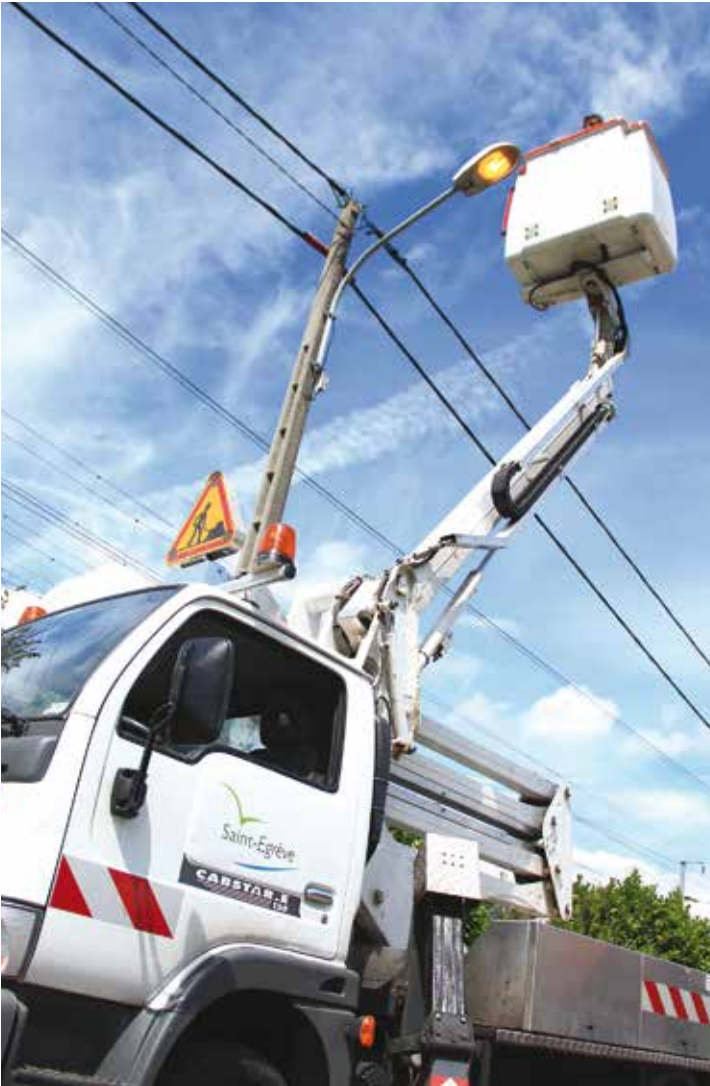
Initiée en 2005, la mise en place d'éclairage économe se termine en 2014
