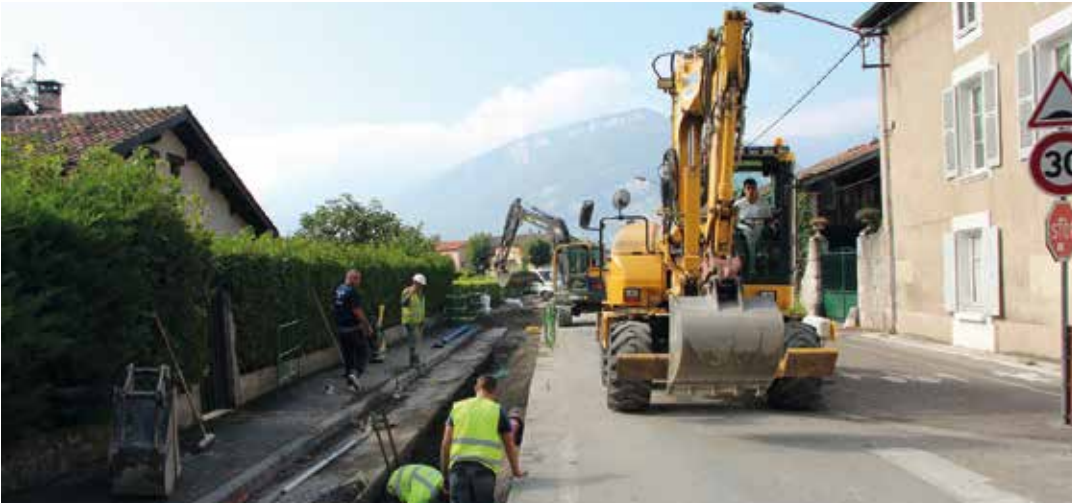
Les travaux de réseaux rue du Muret
