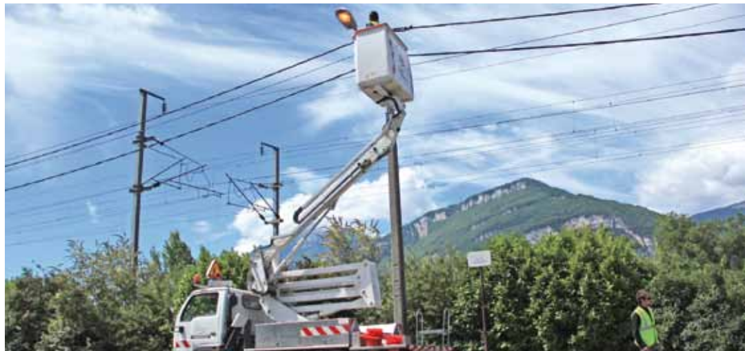
Intervention des agents du Centre technique municipal sur un point d'éclairage public
