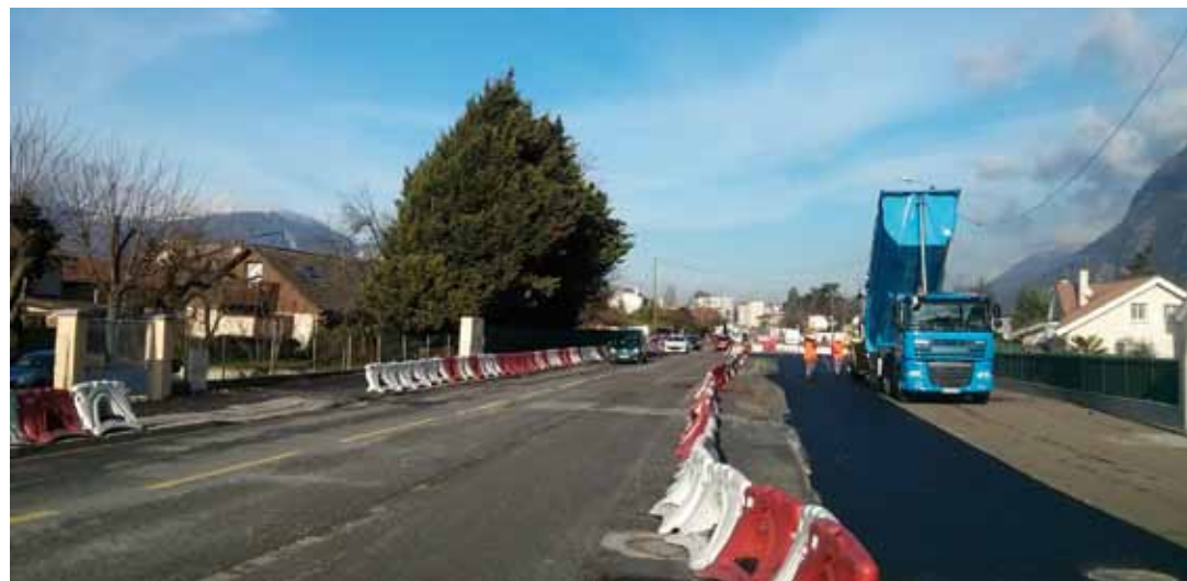
Tram E : les voiries de la route départementale s'élargissent
